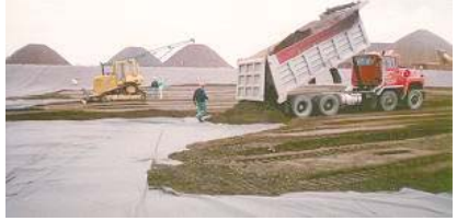
Recubrimiento de la geomembrana
