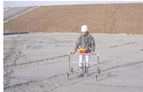
Prospección por medio de dipolo: inspección de la superficie de geomembrana luego del recubrimiento
