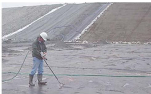
Prospection par jet d'eau: inspection de la surface de géomembrane avant son recouvrement
