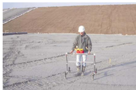
Prospection par dipôle : inspection de la surface de géomembrane après son recouvrement
