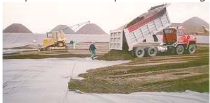
Recouvrement de la géomembrane
